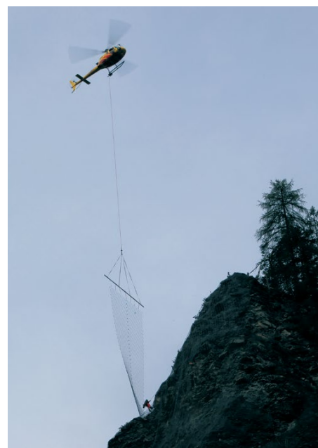
Das Heli-Bernina-Team mit Maurizio Folini als Pilot bei der Montage eines Steinschlagnetzes.
