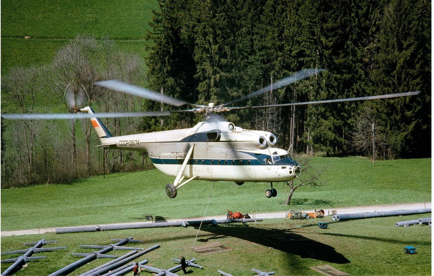
Der russische Mi-6 im April 1966 in Schwellbrunn beim Aufnehmen der Stahlbetonmasten.
