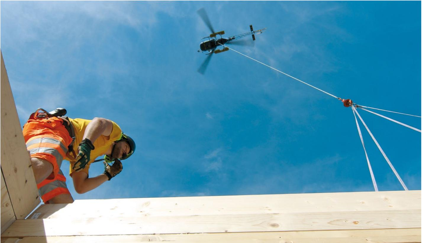
Flughelfer müssen sich nicht nur im Heliflugbetrieb auskennen, oft ist auch das Verständnis für Baustellen gefragt. Hier montiert Alpinlift das nächste Element eines Hauses, das dank Heli-Einsatz innert eines halben Tages aufgerichtet wurde.
